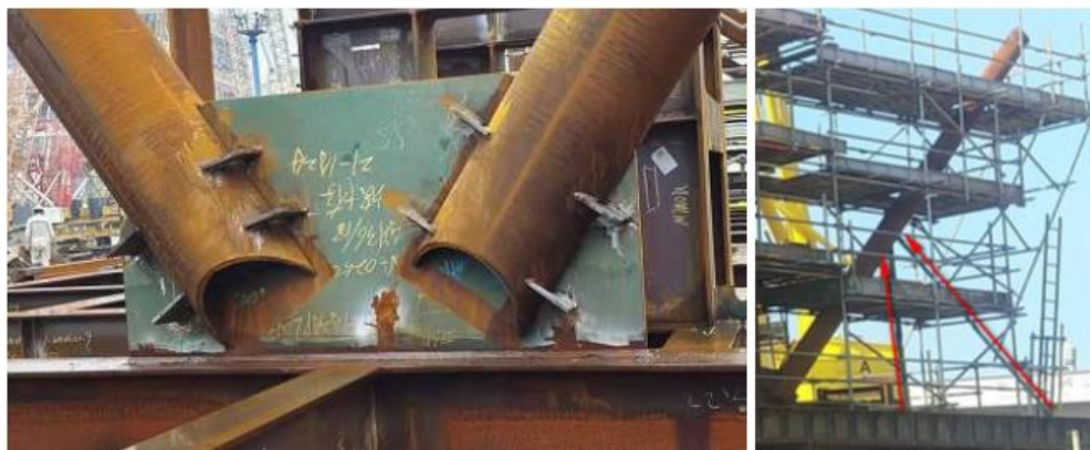
图16 斜拉筋临时安装及支撑
