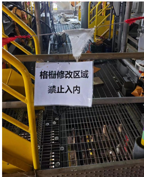
图23 格栅施工区域硬隔离
